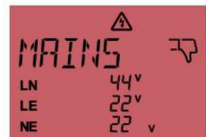
Abb. 11: Nicht bestandene Messung, Messwerte außerhalb des Toleranzbereichs
