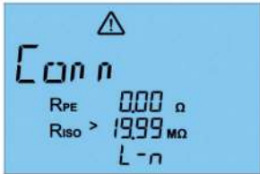
Abb. 45: Prüfung der Verbindung der stromführenden Leiter
